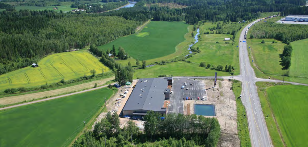
42: Nuijamaantien ja Jysinmäentien risteys vuonna 2008. Pohjoisen suunnasta otetun ilmakuvas keskellä on vastavalmistunut Laplandia Market. Taustalla virtaa Soskuanjoki. Kuvan ylälaidassa keskellä näkyy Saimaan kanava ja oikealla Core Trans Oy:n toimitiloja. (Viistoilmakuva Lappeenrannan kaupunki.)
